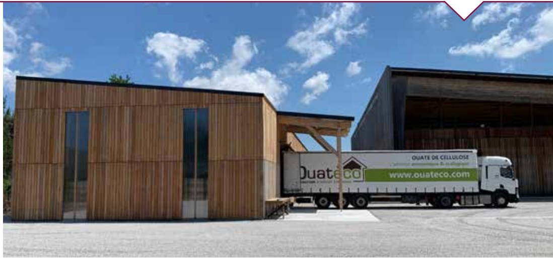
Un nouveau bâtiment bardé en mélèze local est exclusivement dédié à la fabrication et au conditionnement des sacs de Filéco. A terme, ce sont 25 emplois créés.
