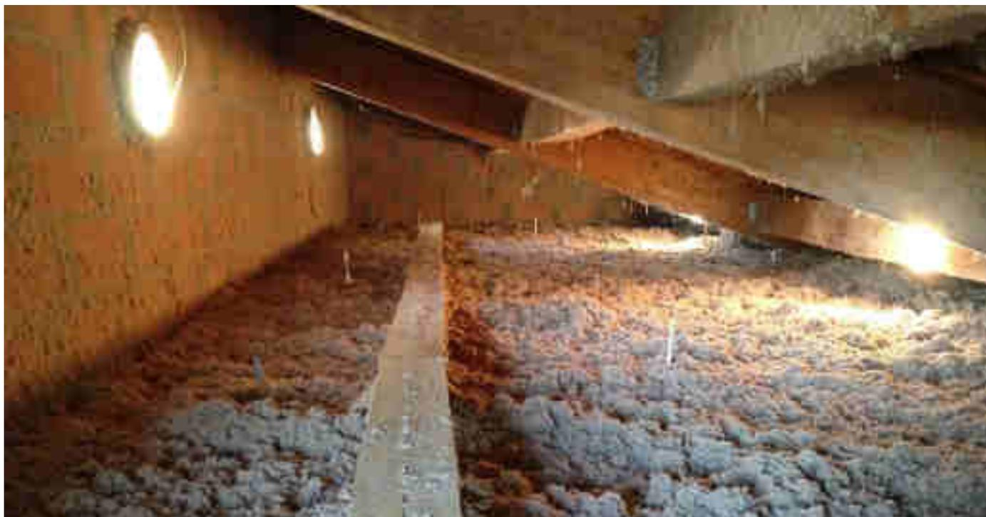
Isolant thermique et acoustique à base de papier recyclé, la ouate de cellulose est utilisée en vrac ou en panneau dans le bâtiment. L'étude initiée par un groupe de travail de fabricants industriels avec le CSTB, interroge la sensibilité réelle de cet isolant en vrac au tassement de son épaisseur au fil des ans. Un enjeu de taille dans un contexte de transition énergétique. Il s'agit d'évaluer la contribution réelle de ce composant à la performance énergétique de l'enveloppe.
